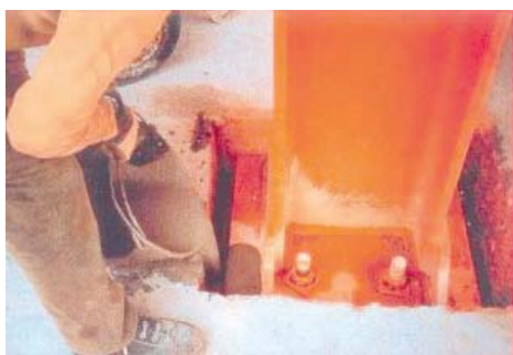
Abocar per colada re-omplint tots els espais.
