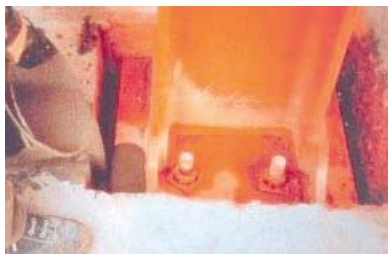
Hacer el vertido de forma rápida y continua.
