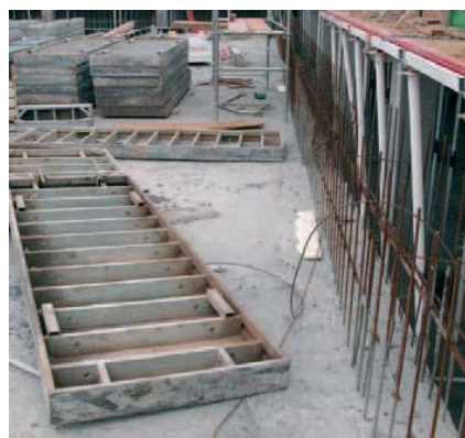
Embutir el FUGA-STOP y hormigonar entre encofrados.
