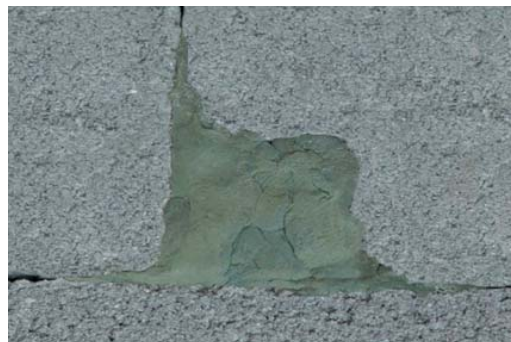
Expandeix segellant la fisura.
