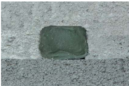
Col·locar-lo rodejat de formigó.
