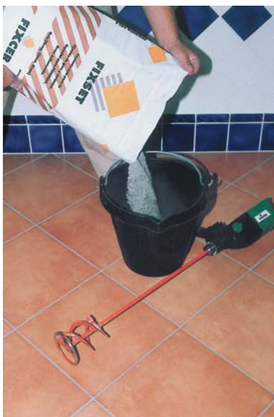
Mesclar amb trepant elèctric.
