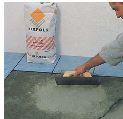
2º pas: passar una llana fina per tal de repartir homogèniament el FIXPOLS .
