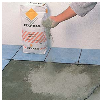
1º paso: espolvoreo de FIXPOLS sobre mortero fresco.
