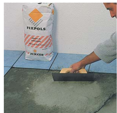
2º paso: pasar una llana fina para repartir homogéneamente el FIXPOLS .
