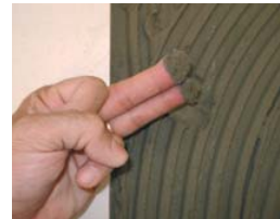
Vérifier que le ciment est frais.
