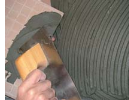
Utiliser la technique du double encollage.
