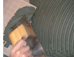
Usar la técnica del doble encolado.
