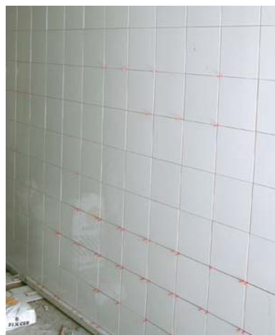
Col·locació de rajoles de València sobre arrebossats de guix.
