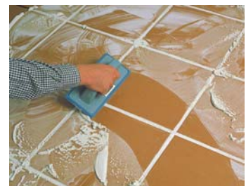
Jointoiement 24 heures après la pose
