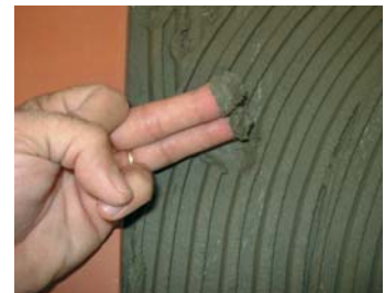
Vérifier que le ciment est bien frais.
