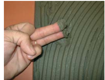
Comprobar que el cemento esté fresco.
