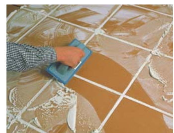
Rejuntar passadas 24 horas após a colocação.
