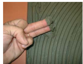
Confirmar se o cimento está fresco.
