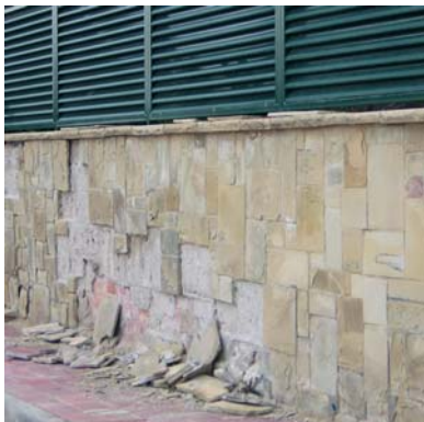
Las consecuencias de no usar un cemento adecuado.
