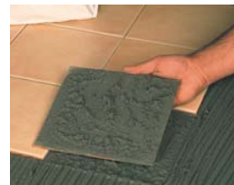
Comprobar el contacto cerámica-cemento.
