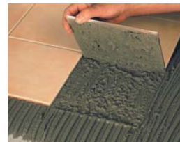
Vérifier que le ciment est frais.
