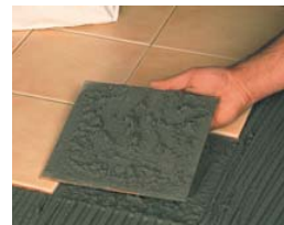
Vérifier le contact céramique - ciment.
