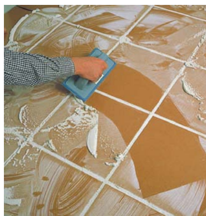
Rejuntat de les platges de les piscines.
