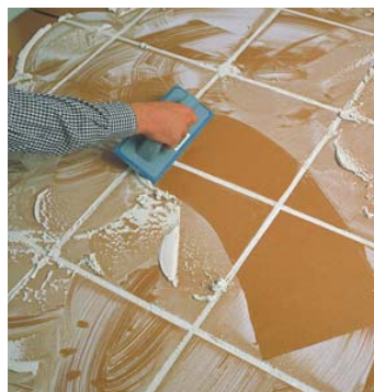
Scellage des joints de grès résidentiel.
