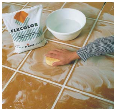
Primera limpieza con esponja humedecida con agua.
