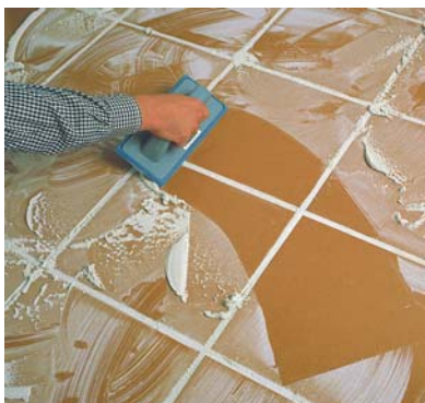
Rellenar las juntas con ayuda de la FIX-ESPATULA
