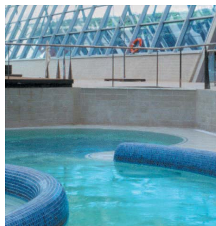
Rejuntat de mosaic de vidre.
