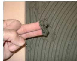
Comprobar que el cemento esté fresco.
