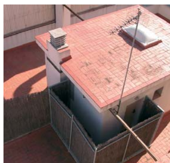
Re-impermeabilizamos respetando la estética original.
