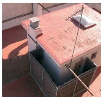
Re-imperméabilisation selon l'esthétique originelle.
