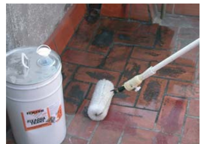
... aplicar con rodillo resistente a los disolventes.
