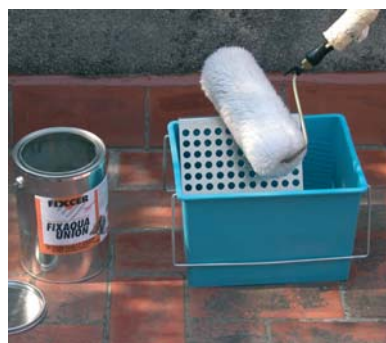
Aplicar previamente la imprimación de FIXAQUA UNION
