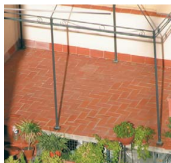
Impermeabilización de terrazas y azoteas.
