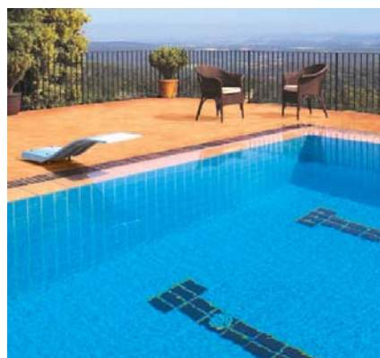
Impermeabilització en terrenys no estables.
