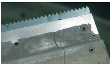
Pels terres: usar una llana de 3 mm.
