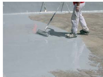
Desairear el poliuretano en fresco con rodillo de púas.
