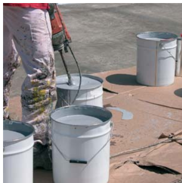
Añadir el acelerante y mezclar con batidor 2 minutos.
