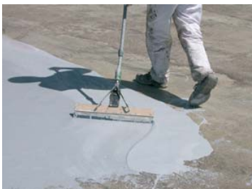
Aplicar con llana dentada de dentro hacia fuera.
