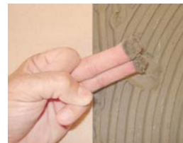
Utiliser la technique du double encollage.
