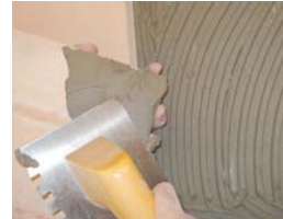
Utiliser la technique du double encollage.
