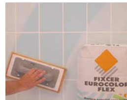
Joints 24 heures après la pose.
