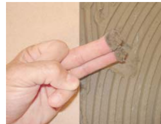
Comprovar que el ciment estigui fresc.
