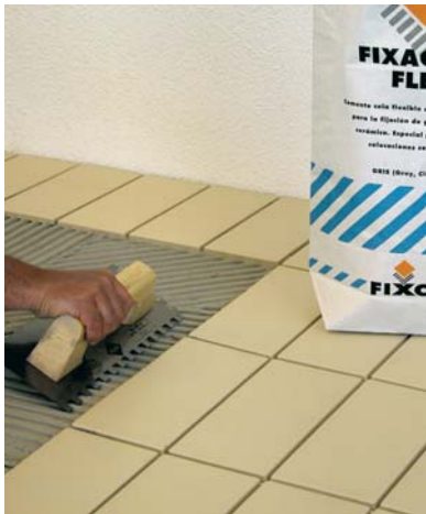
Col·locació de plaquetes industrials amb la màxima adhesió.
