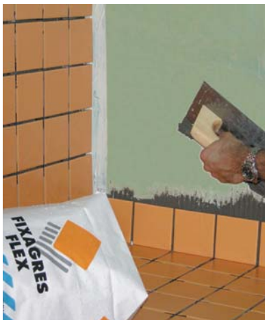
Col·locació de ceràmica en banys sobre de la impermeabilització de HIDROFILM .
