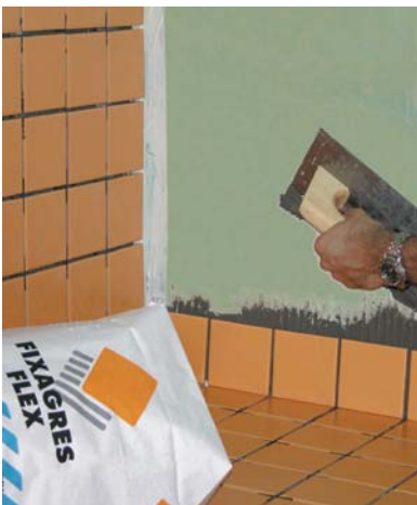
Pegado de cerámica en baños sobre la impermeabilización de HIDROFILM .
