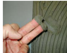
Vérifier que le ciment est frais.
