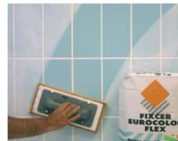
Jointer 24 heures après la pose.
