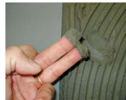
Comprobar que el cemento esté fresco.
