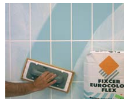
Rejuntar pasadas 24 horas de la colocación.
