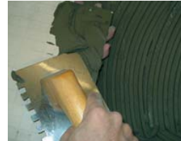
Usar la técnica del doble encolado.
