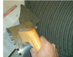
Utiliser la technique du double encollage.
