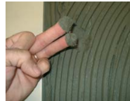
Utiliser la technique du double encollage.
