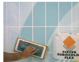
Jointer 24 heures après la pose.
