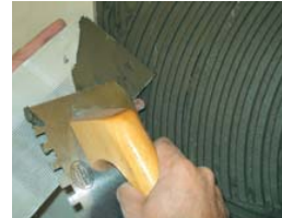
Usar la técnica del doble encolado.
