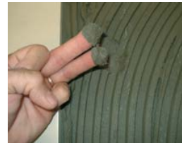
Comprobar que el cemento esté fresco.
