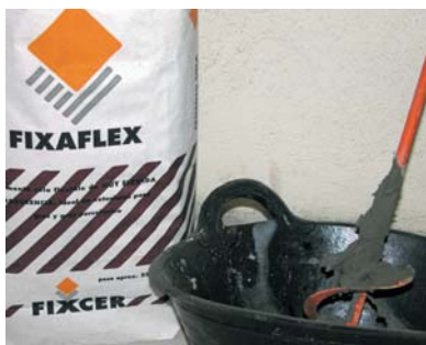
Mesclar amb trepant elèctric.
