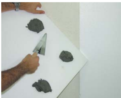
Pegado por puntos de paneles aislantes.
