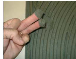
Comprobar que el cemento esté fresco.
