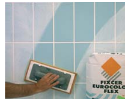
Rejuntar pasadas 24 horas de la colocación.
