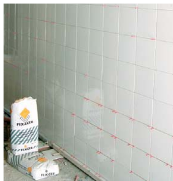
Para pegar azulejos en interiores.
