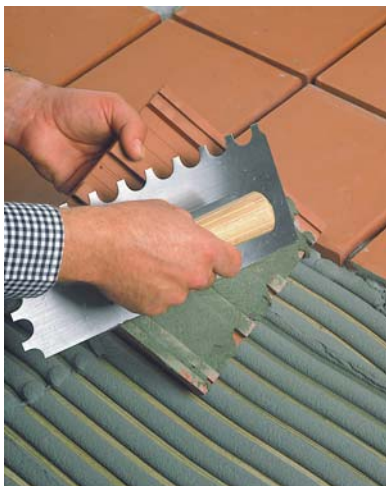
Rellenar reversos estriados o con cola de milano.
