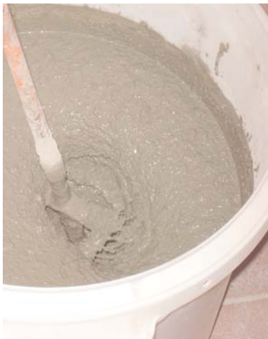
Utilizar um misturador eléctrico com baixa rotação.
