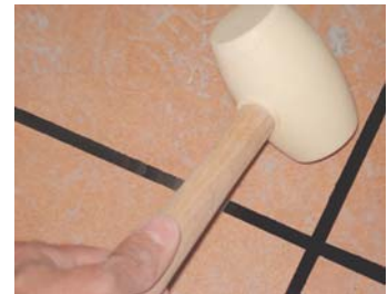
Utiliser un maillet en caoutchouc.
