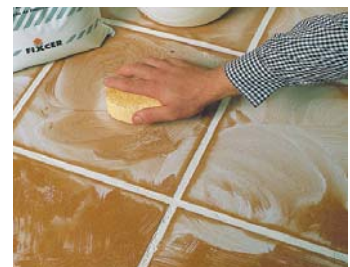
Jointoiement 24 heures après la pose
