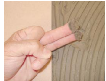
Comprobar que el cemento esté fresco.
