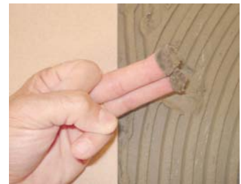
Confirmar se o cimento está fresco.
