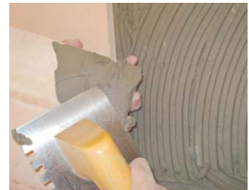
Utilizar a técnica de colagem nas duas faces.
