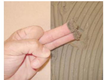
Comprovar que el ciment estigui fresc.
