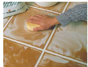
Rejuntar passades 24 hores de la col.locació.
