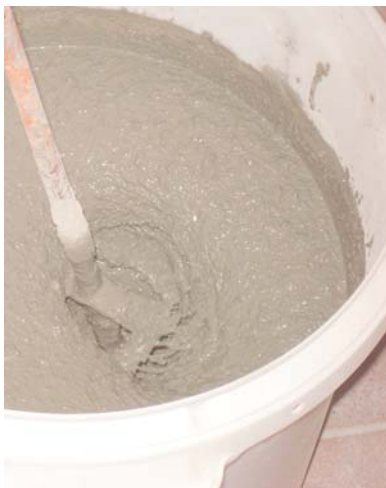
Usar mezclador eléctrico a bajo n° de r.p.m.
