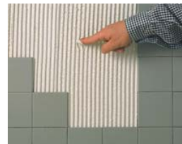
Comprobar que el cemento esté fresco.
