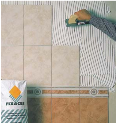
Colocación sobre revoques de escayola.
