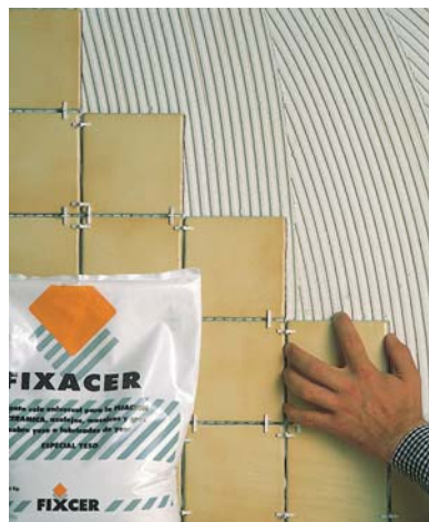
Colocación sobre revoques de yeso.
