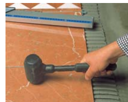
Utiliser un maillet en caoutchouc.
