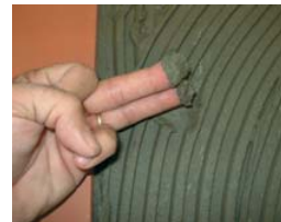
Utiliser la technique du double encollage.
