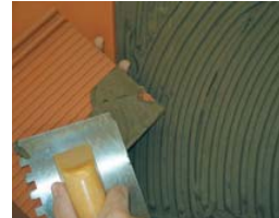
Utiliser la technique du double encollage.
