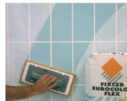
Jointer 24 heures après la pose.
