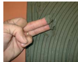
Comprobar que el cemento esté fresco.
