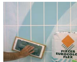
Rejuntar pasadas 24 horas de la colocación.
