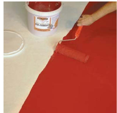
Una volta trascorse 24 ore applicare la 2ª mano
